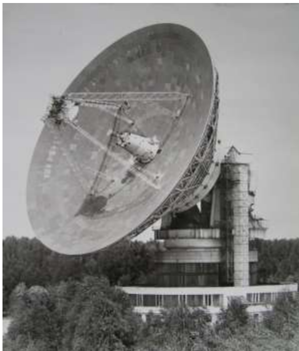
Фото 18. Антенная система ТНА - 1500, диаметр зеркала 69 метров.
